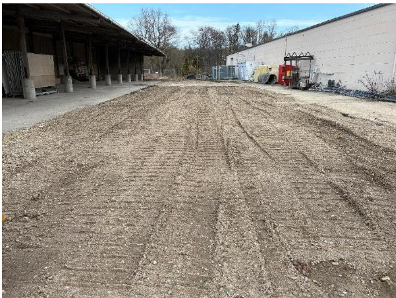
Foto 12: Aufgebrochene Sanierungsfläche
