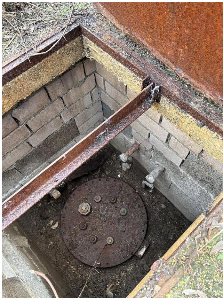
Foto 10: Domschacht verbliebener Tank
