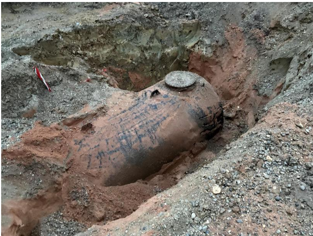
Foto 22: Freigelegter 30 000 l Dieseltank
