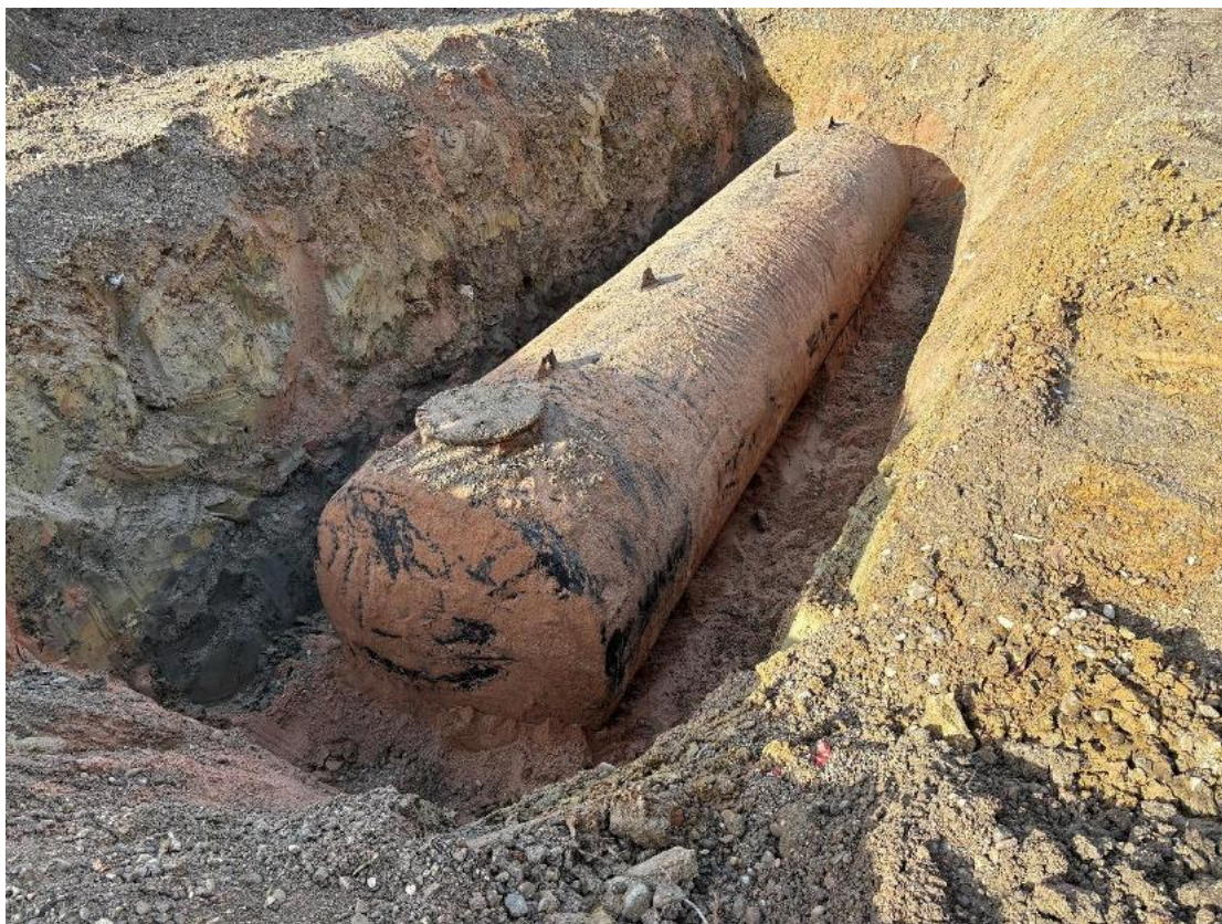
Foto 23: Freigelegter 30 000 l Dieseltank
