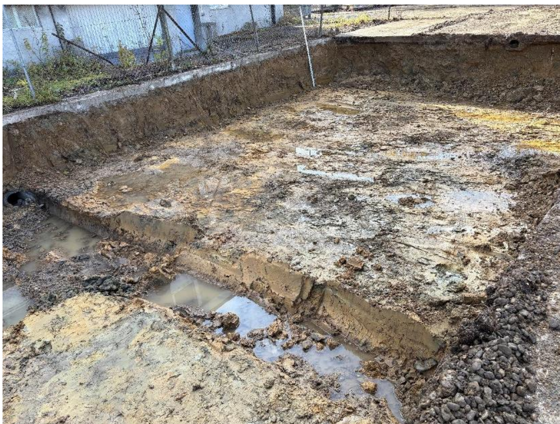
Foto 8: Ausgehobener Bereich (SF-1)
