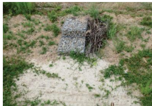
Steinkörbe mit Überdeckung (BILANUM 2019)
