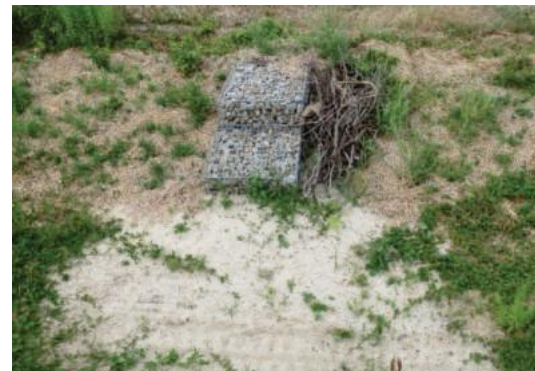
Steinkörbe mit Überdeckung (BILANUM 2019)
