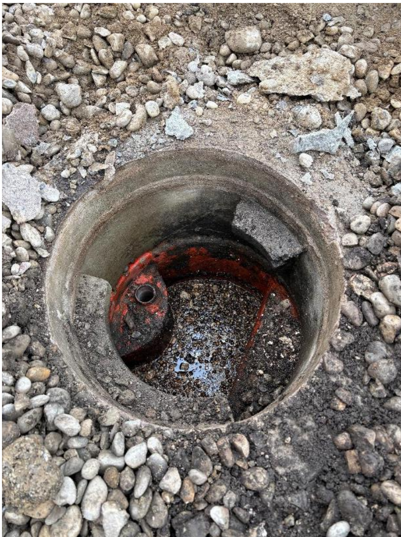
Foto 4: Ölabscheider (SB-1)
