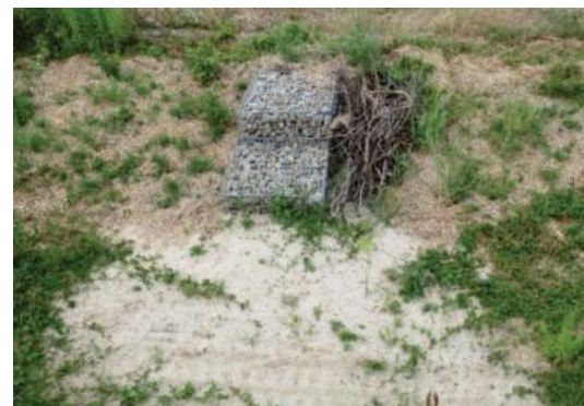
Steinkörbe mit Überdeckung (BILANUM 2019)
