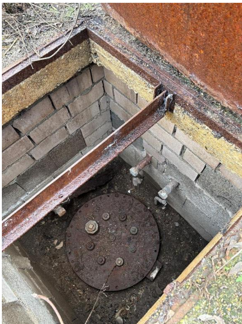
Foto 10: Domschacht verbliebener Tank
