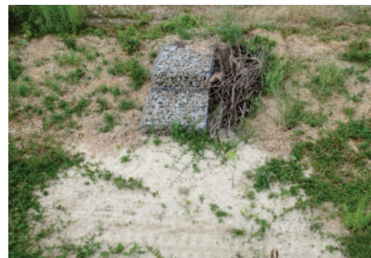
Steinkörbe mit Überdeckung (BILANUM 2019)
