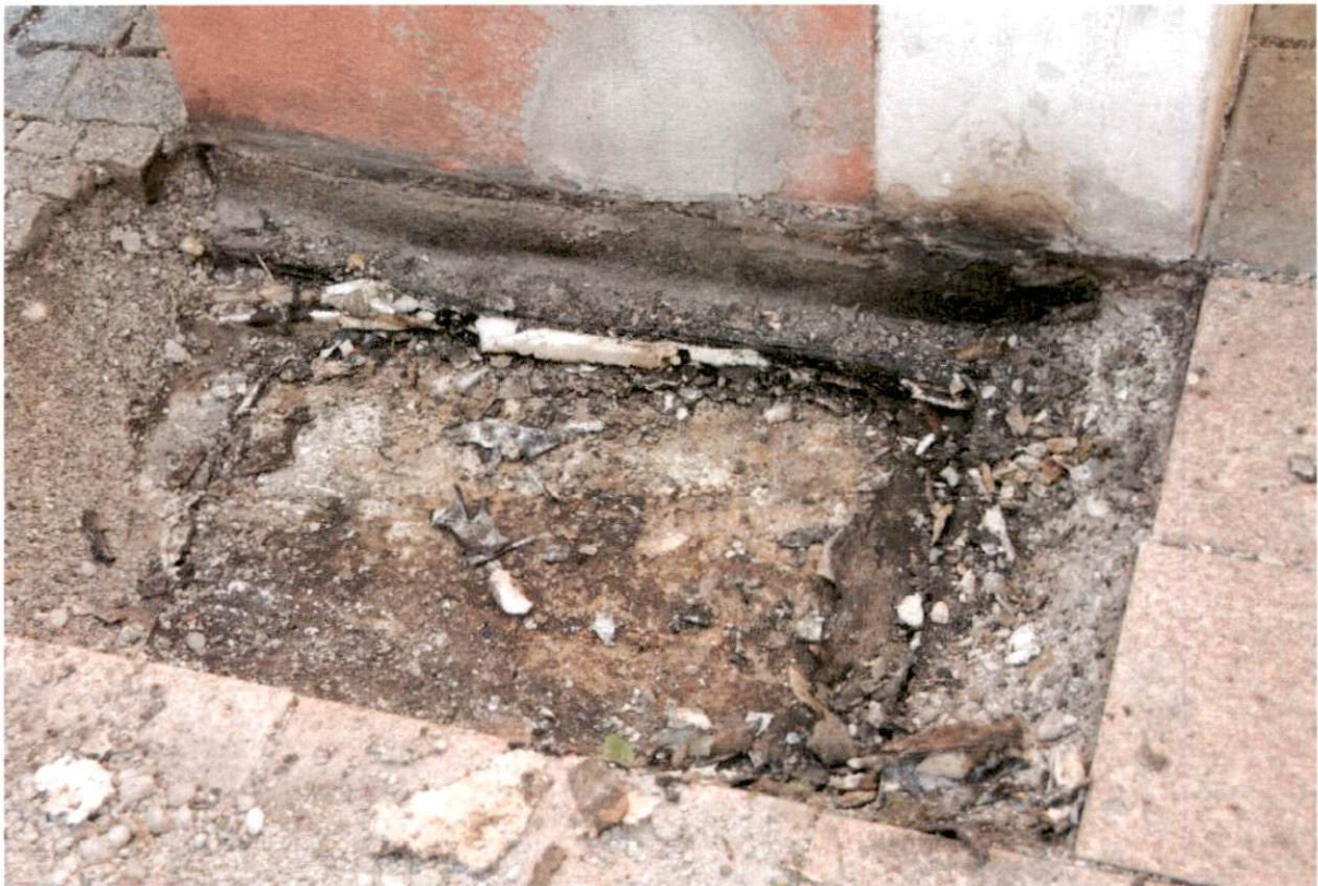
Abb. 8: Aufbau im Außenbereich im Bereich der überpflasterten Stahlbetondecken der Tiefgarage.
