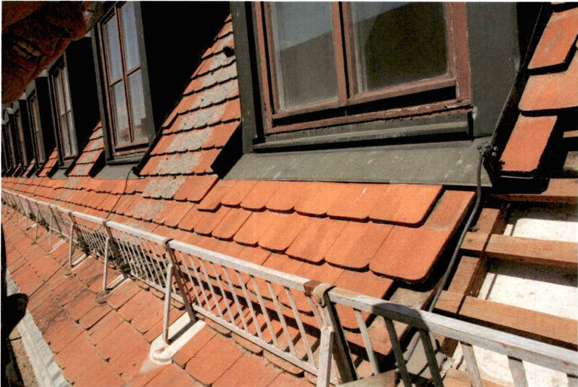
Abb. 5: Ansicht Dachfläche im Traufbereich
