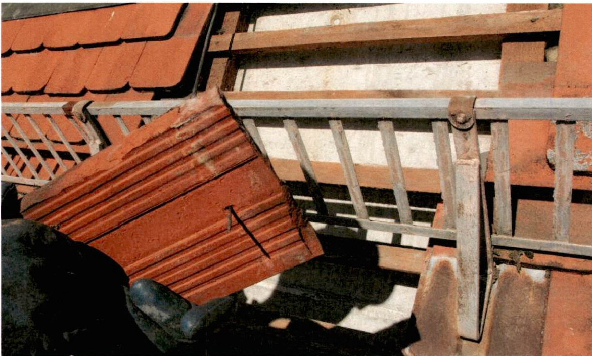
Abb. 4: Gekürzte Biberschwanzplatte mit stark korrodierten Nagel
