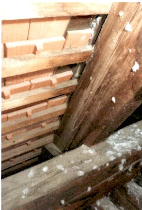
Abb. 12: Feuchtigkeitsspuren im Dachspitz, Befestigung der geschnittenen Dachplatten
