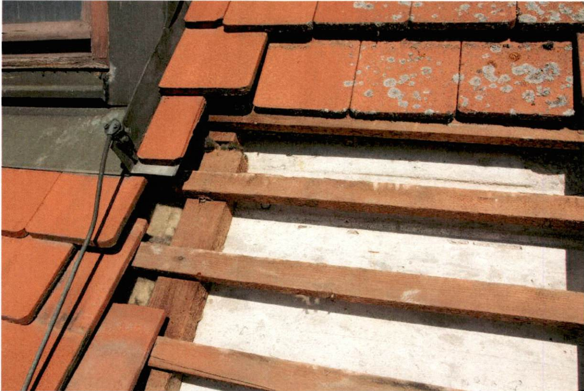
Abb. 3: Dachaufbau im Bereich Sargdeckel
