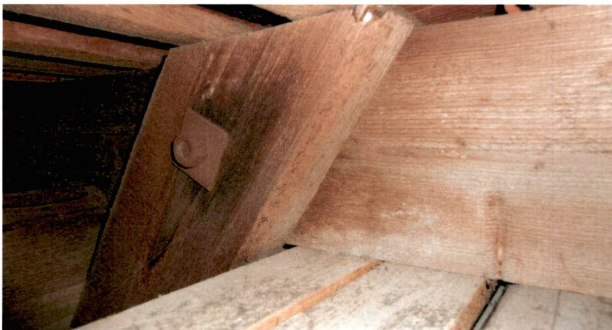
Abb. 13: Knotenpunkt Sparren mit Kehlbalkenanschluss
