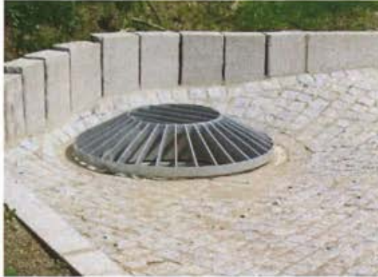
Abbildung 9-1: Gitterabdeckung als Pyramidenstumpf – Beispiel
