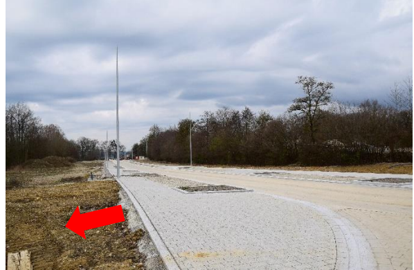
Abbildung 12: Dr.-Alfred-Böswald-Ring, Blick nach Westen; links befindet sich das Baugrundstück der Panoramahäuser
