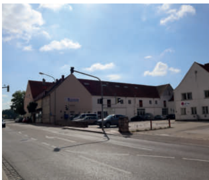
Zugangsbereich Kapellstr. / Untergenutz
