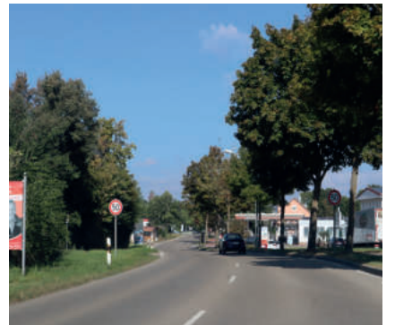
Zentrale Stadtzufahrt Augsburger Straße
