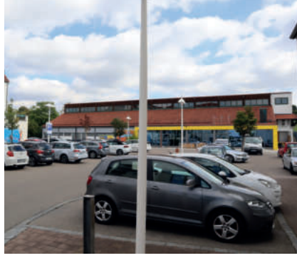
Nahversorgungszentrum an der Berger Vorstadt
