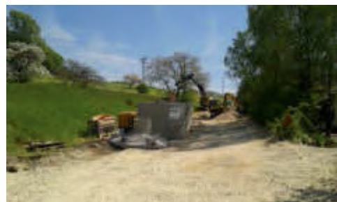
Kanalbau im Baugebiet Zirgesheim-Ost (Stillbergweg)
