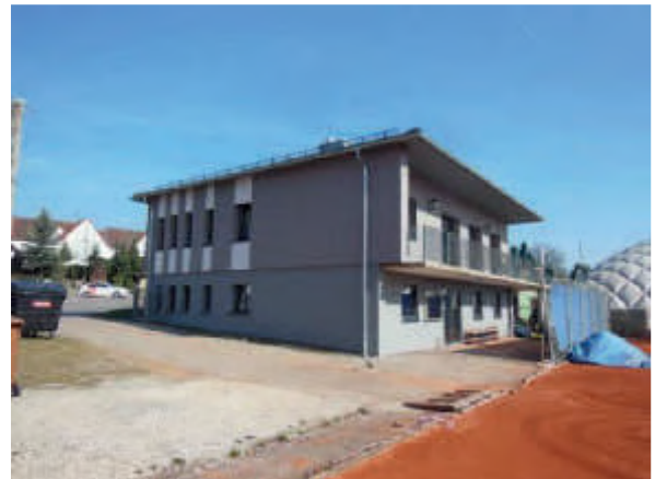
Tennisheim nach der Brandsanierung
