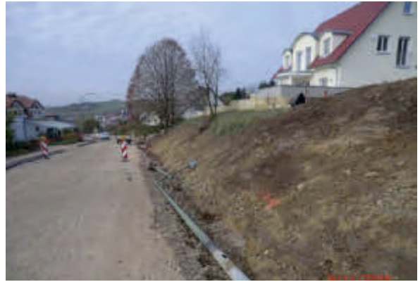
Neues Baugebiet „Nördlich des Stillbergweges“ in Zirgesheim
