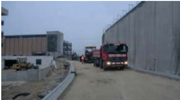
Neubau der Eduard-Rüber-Straße am Bahnhof
