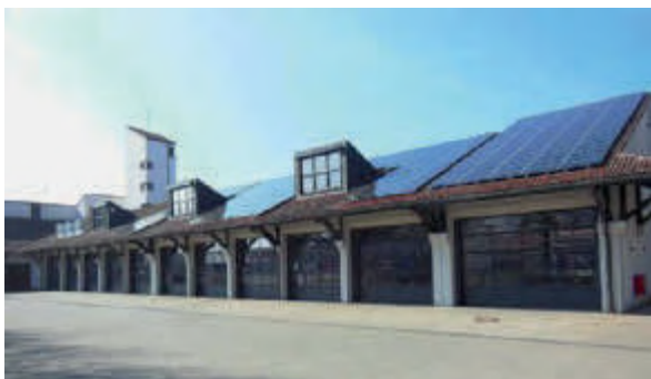
Neue Sektional-Tore der Feuerwehr-Fahrzeughalle
