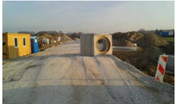
Kanalarbeiten im Gewerbegebiet Südspange
