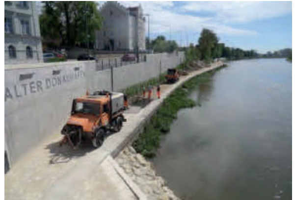
Arbeiten am Alten Donauhafen
