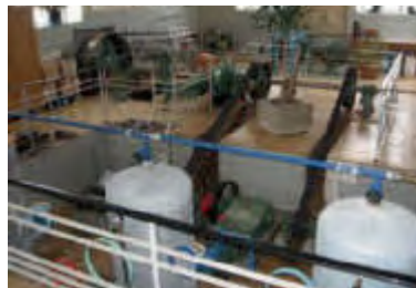
Erneuerung von Kolbenpumpen, Mühlweg 6
