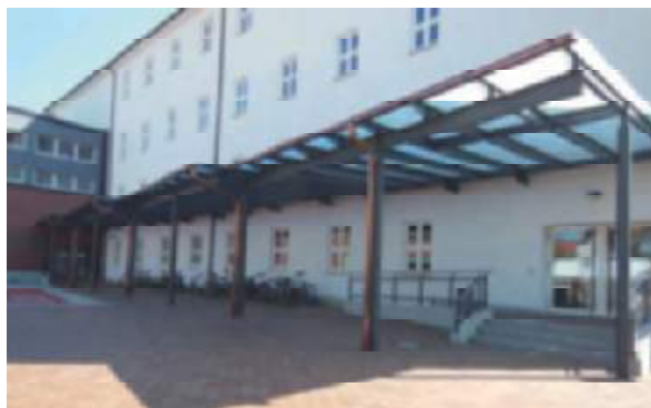
Neues Vordach an der Mangoldschule.
