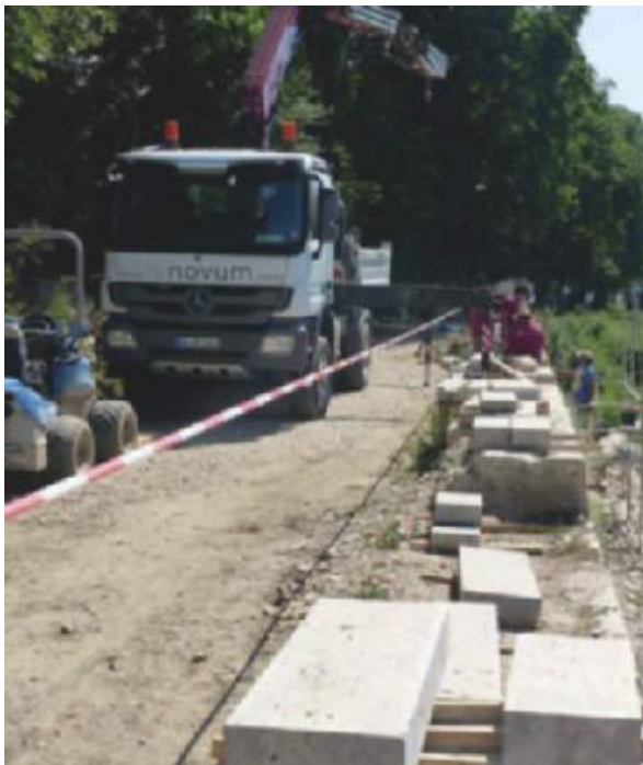
Arbeiten am Alten Donauhafen.
