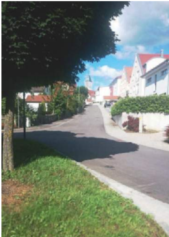
Ausbau des Mühlwegs.
