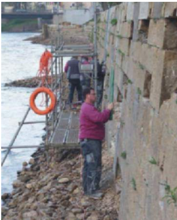
Sanierung der Ufermauer am Alten Donauhafen.
