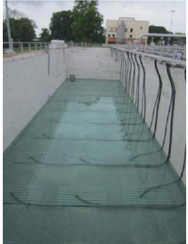
Sanierung und Umbau des Belebungsbeckens in der Kläranlage Donauwörth.
