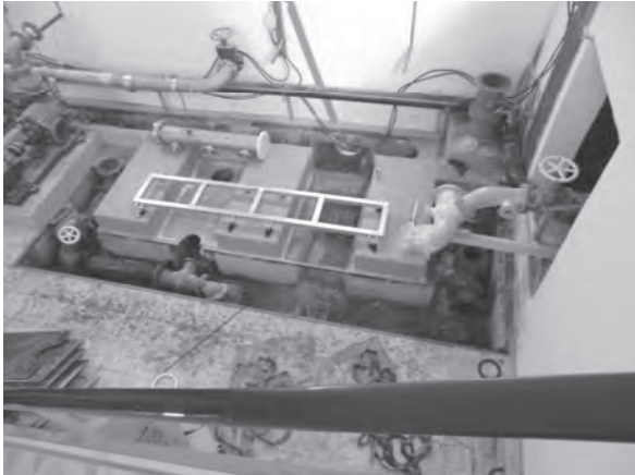
Druckerhöhungsanlage im Bau
