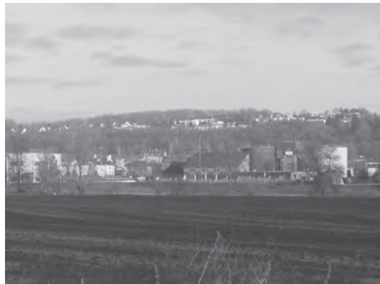
Ansicht des Klärwerks von Süden
