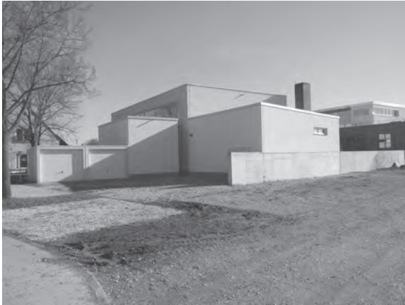
Anbau Turnhalle Nordheim
