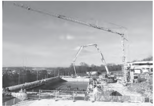
Sanierung des Schwimmerbeckens
