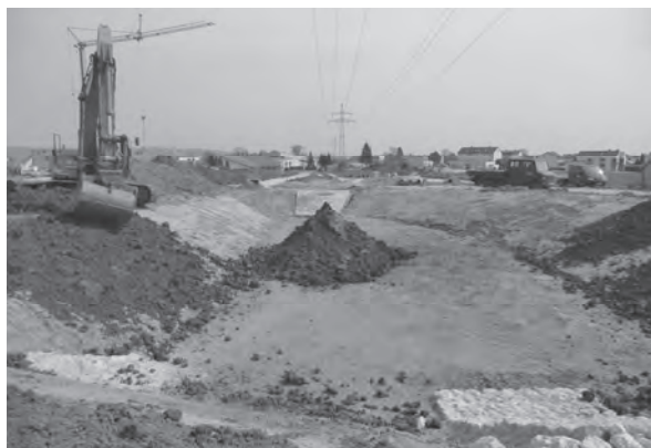
Regenrückhaltebecken Wohnpark Mitte
