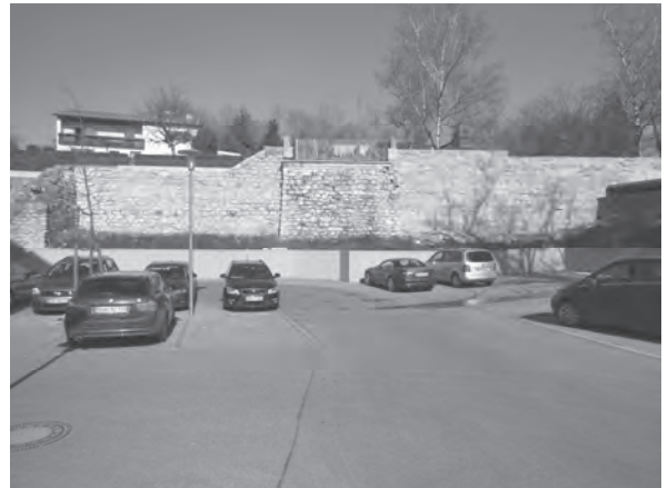
Restauriertes Mauerwerk Promenade
