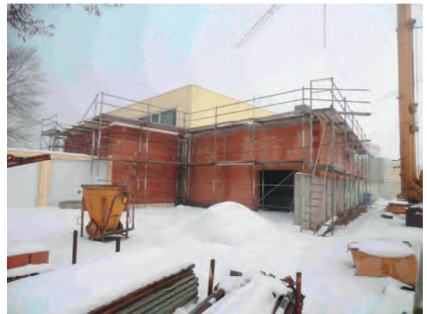
Anbau Turnhalle Nordheim
