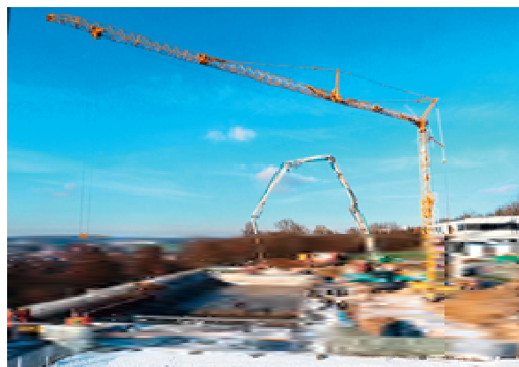
Sanierung des Schwimmerbeckens im Freibad am Schellenberg
