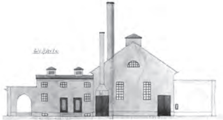
Gebäudeansicht des Donauwörther Gaswerks (Westen)
