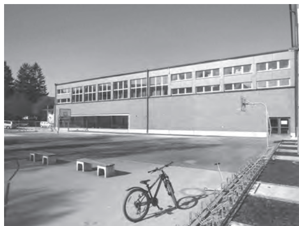
Mangoldschule: Fassade der Turnhalle
