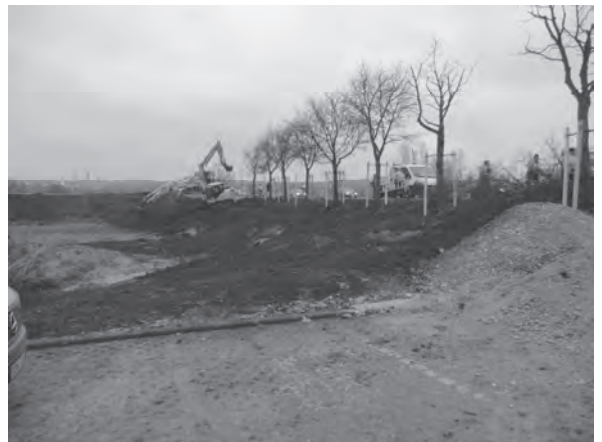
Bauarbeiten an der Westspange
