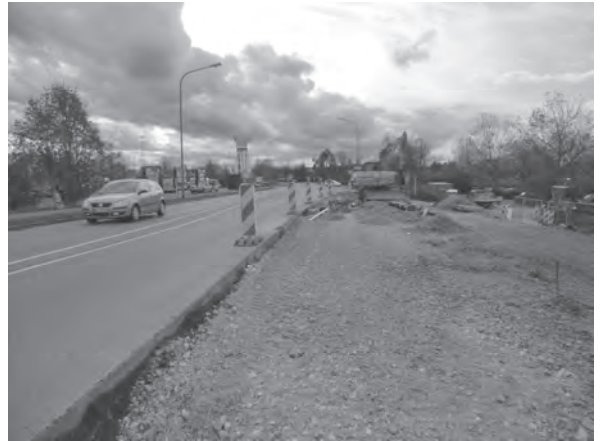
Bauarbeiten an der Westspange
