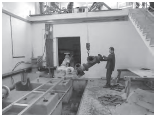
Druckerhöhungsanlage im Bau
