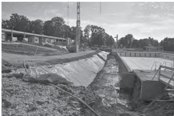
Die Sanierung hat begonnen!
