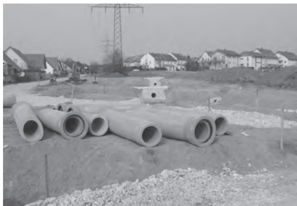
Regenrückhaltebecken Wohnpark Mitte
