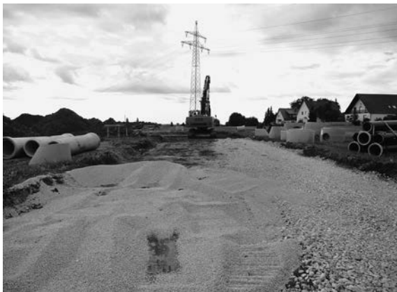
Kanalisation Baugebiet Wohnpark 5 BA 3
