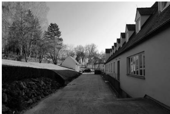
Drainage Kindergarten im Schneegarten
