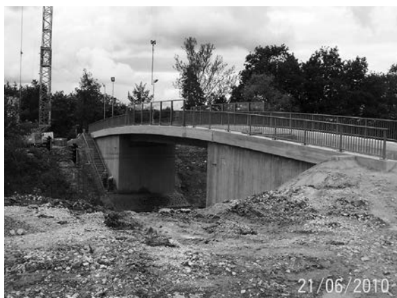
Neubau Brücke Binsberg
