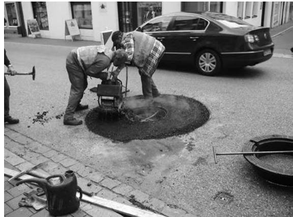
Sanierung Kanalschachtabdeckungen
