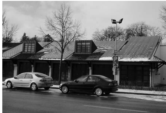
Photovoltaikanlage Dach Feuerwehrhaus Donauwörth
