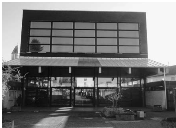
Erneuerung Vordach Aussegnungshalle Friedhof
