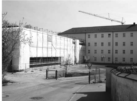
Sanierung Fassade Turnhalle Mangoldschule
