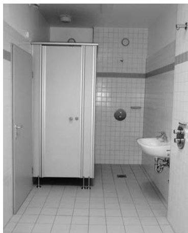
Sanierung Duschen, Umkleiden Neudegger Sporthalle
