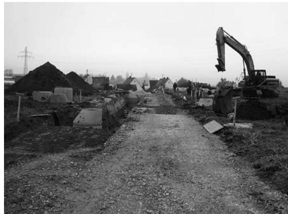
Bauarbeiten Erschließung Baugebiet Wohnpark 5
