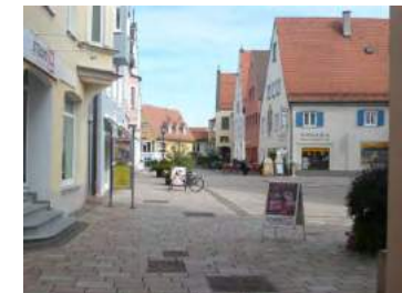
Erfolgreiche Sanierung des öffentlichen Raums auf der Insel Ried
