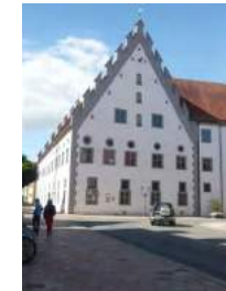
Stadtbildprägende Einzelgebäude (Fuggerhaus) in gutem Zustand
